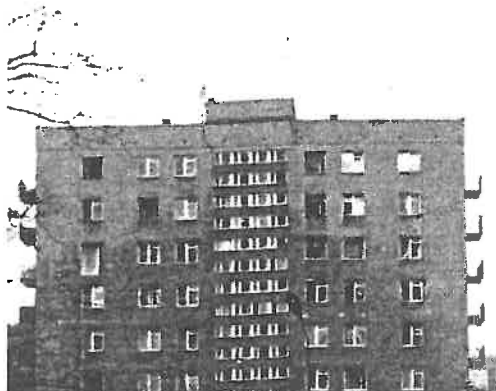
Rys. 8. Górne piętra tylnej elewacji budynku
