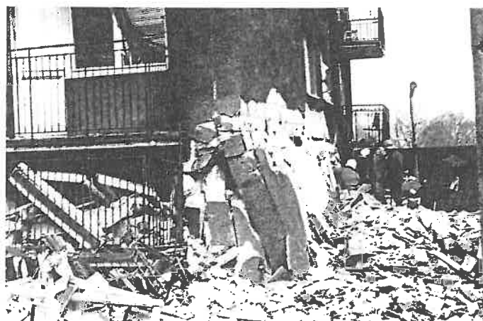
Rys. 12. Dolny fragment naroża ściany głównej i szczytowej
