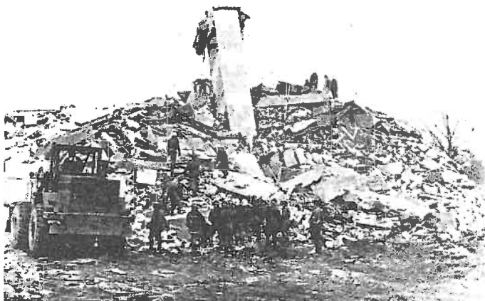
Rys. 13. Ruiny budynku wysadzonego wybuchem pirotechnicznym
